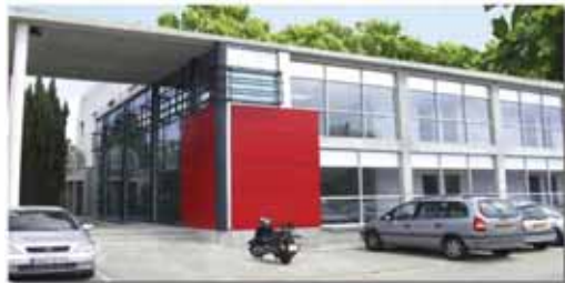
Bâtiment Jean LAGASSE
